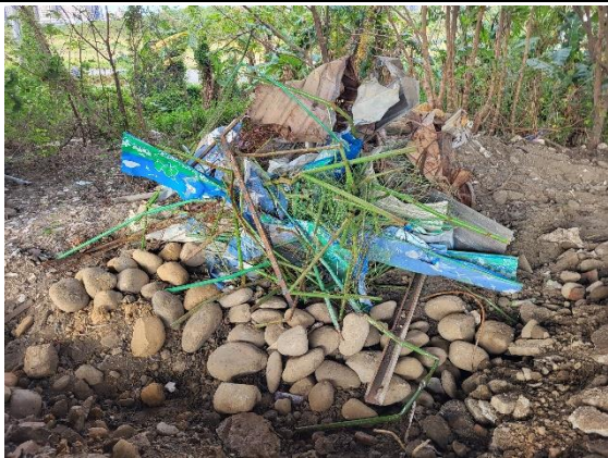
工程廢棄物集中處理
