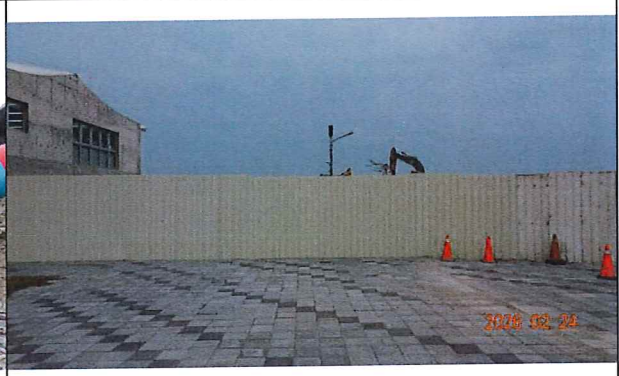
已於工區周遭設置工程圍籬
