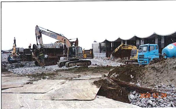
施工現場機具運作情況
