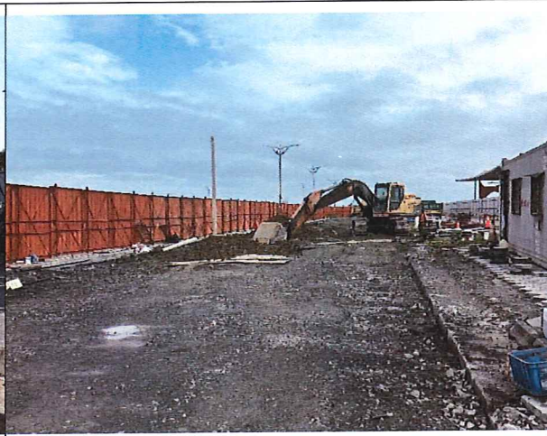
已於工區周遭設置工程圍籬
