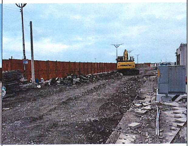
已於工區周遭設置工程圍籬
