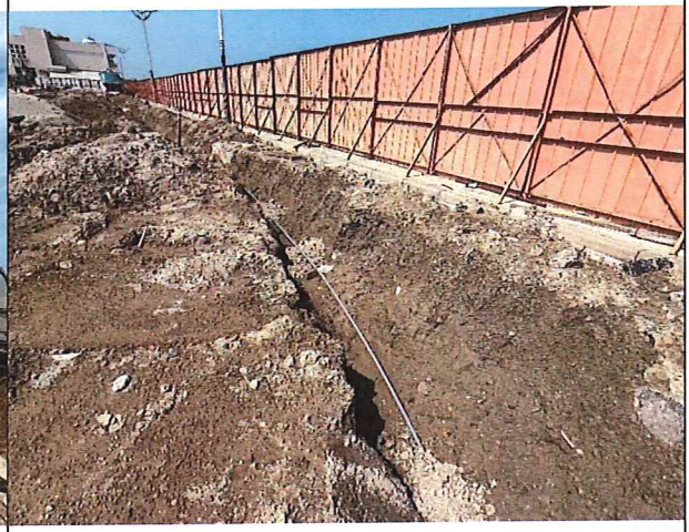
已於工區周遭設置工程圍籬
