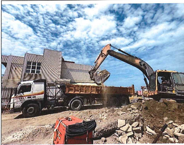
施工現場機具運作情況
