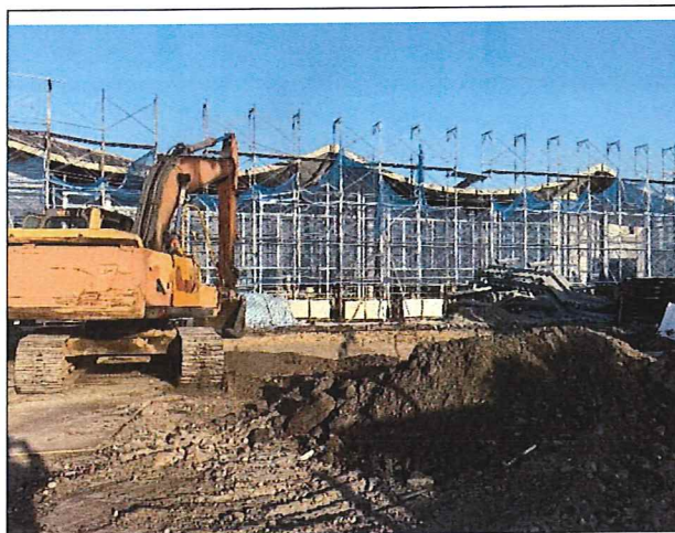
施工現場機具運作情況
