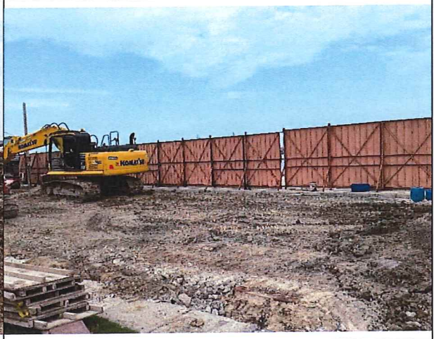
已於工區周遭設置工程圍籬
