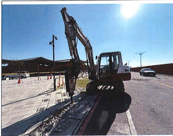
施工現場機具運作情況
