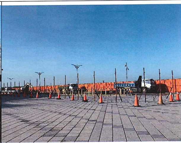
已於工區周遭設置工程圍籬
