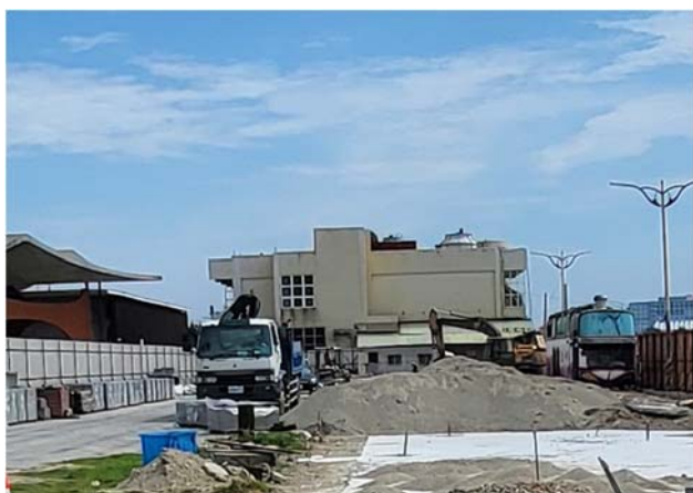
舊直銷中心尚未拆除
