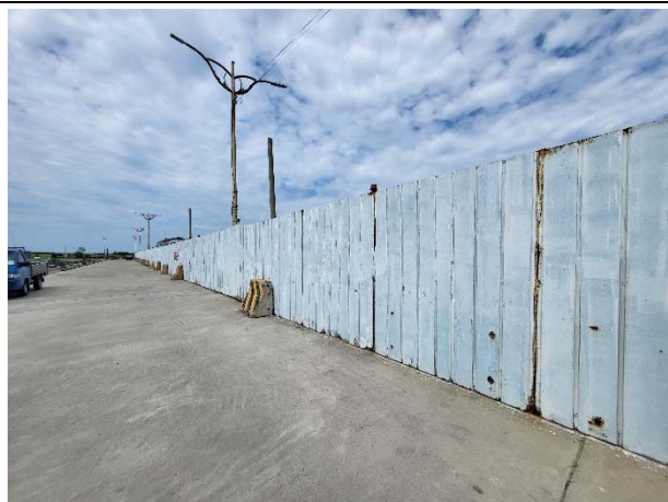
已設置施工圍籬
