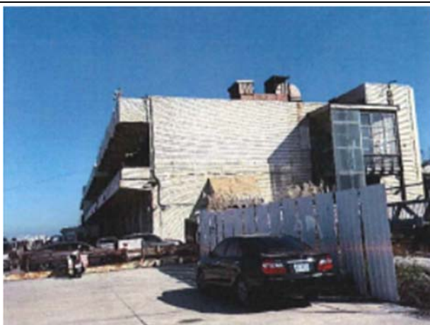
舊直銷中心尚未拆除
