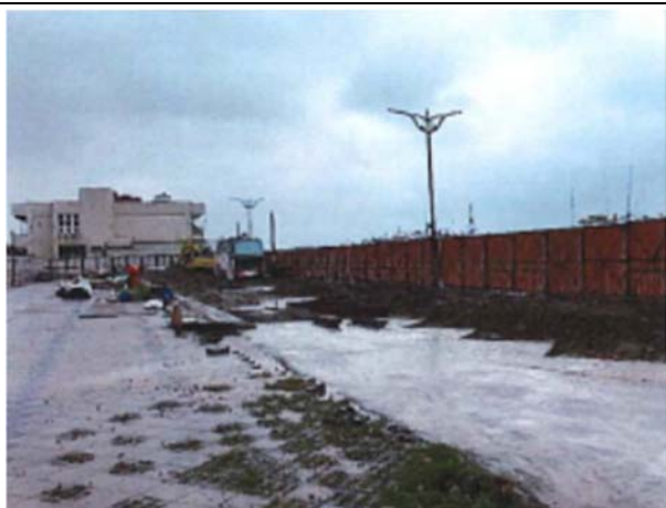
舊直銷中心尚未拆除
