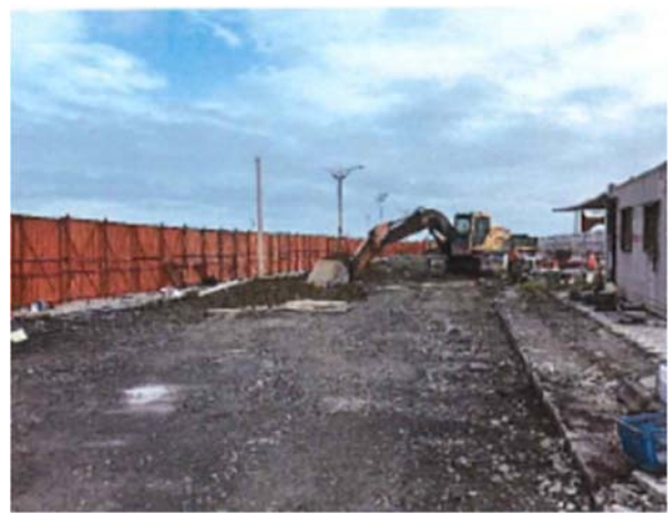
已設置施工圍籬
