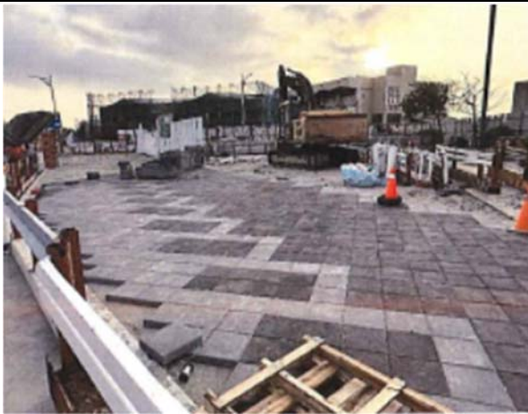
舊直銷中心尚未拆除
