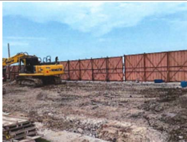
已設置施工圍籬
