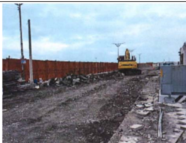
已設置施工圍籬
