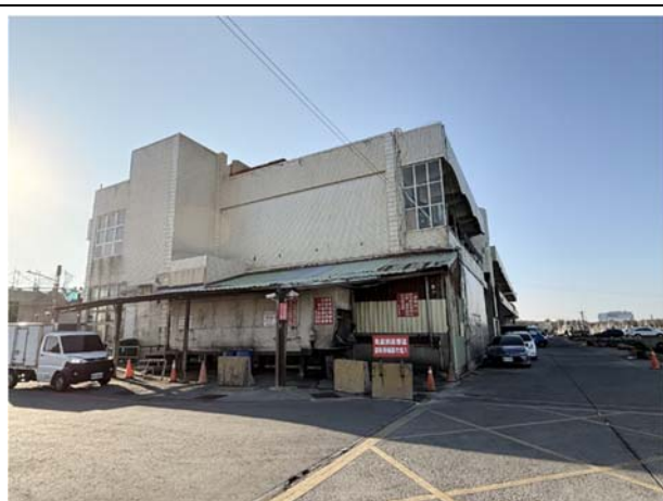
舊直銷中心尚未拆除
