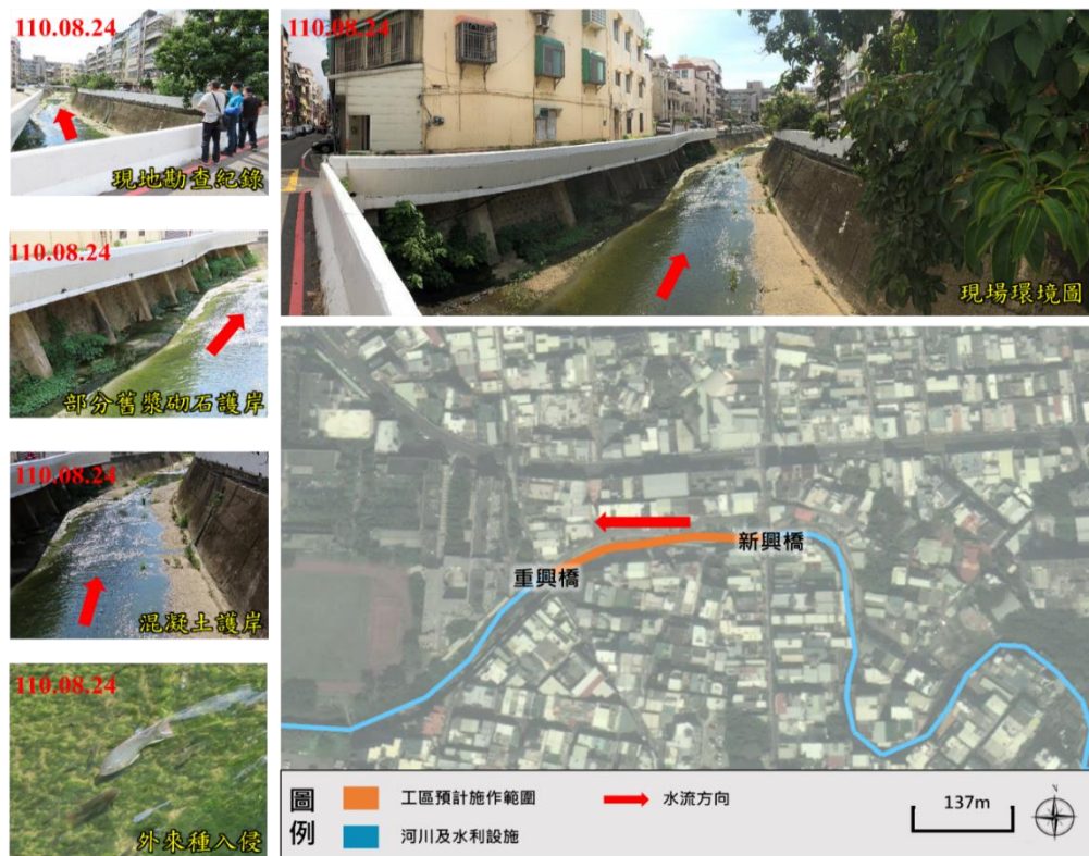
圖 2-3 南門溪排水(河心累距 0K+421~0K+558)護岸改善應急工程環境現況圖
