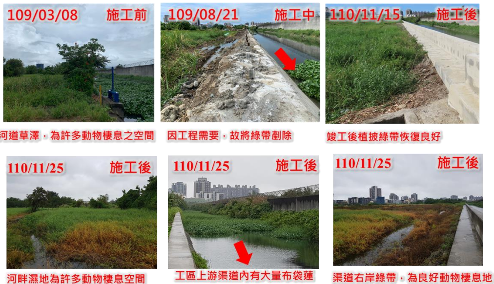
圖 2-40 港北排水支線(3K+091-791)右岸棲地影像監測圖
