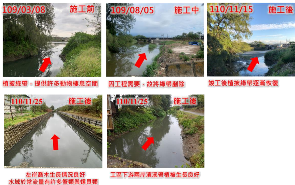
圖 2-47 港北金城橋排水幹線護岸新建應急工程(OK+090-OK+302)棲地影像監測圖
