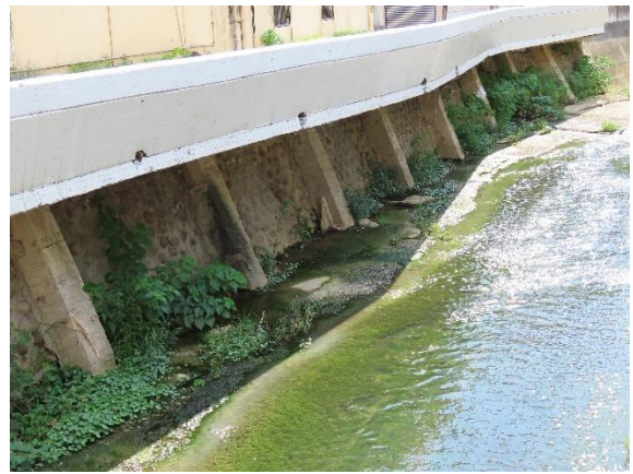
水岸及護岸照片
