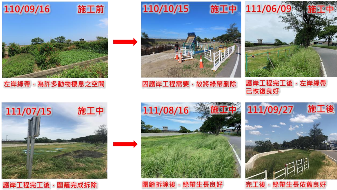
(a)施工前、中、後之工區植被情況
