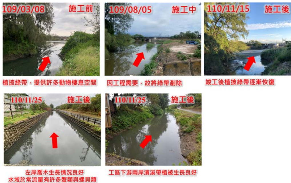
圖 49 港北金城橋排水幹線護岸新建應急工程(0K+090-0K+302)棲地影像監測圖
