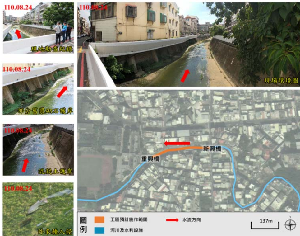
圖 12 南門溪排水(河心累距 0K+421~0K+558)護岸改善應急工程環境現況圖
