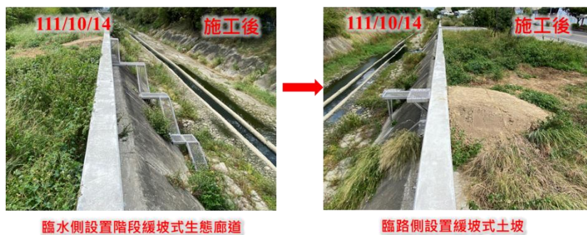
(c)施工後之生態廊道照片
