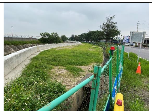
工區棲地回覆情況
