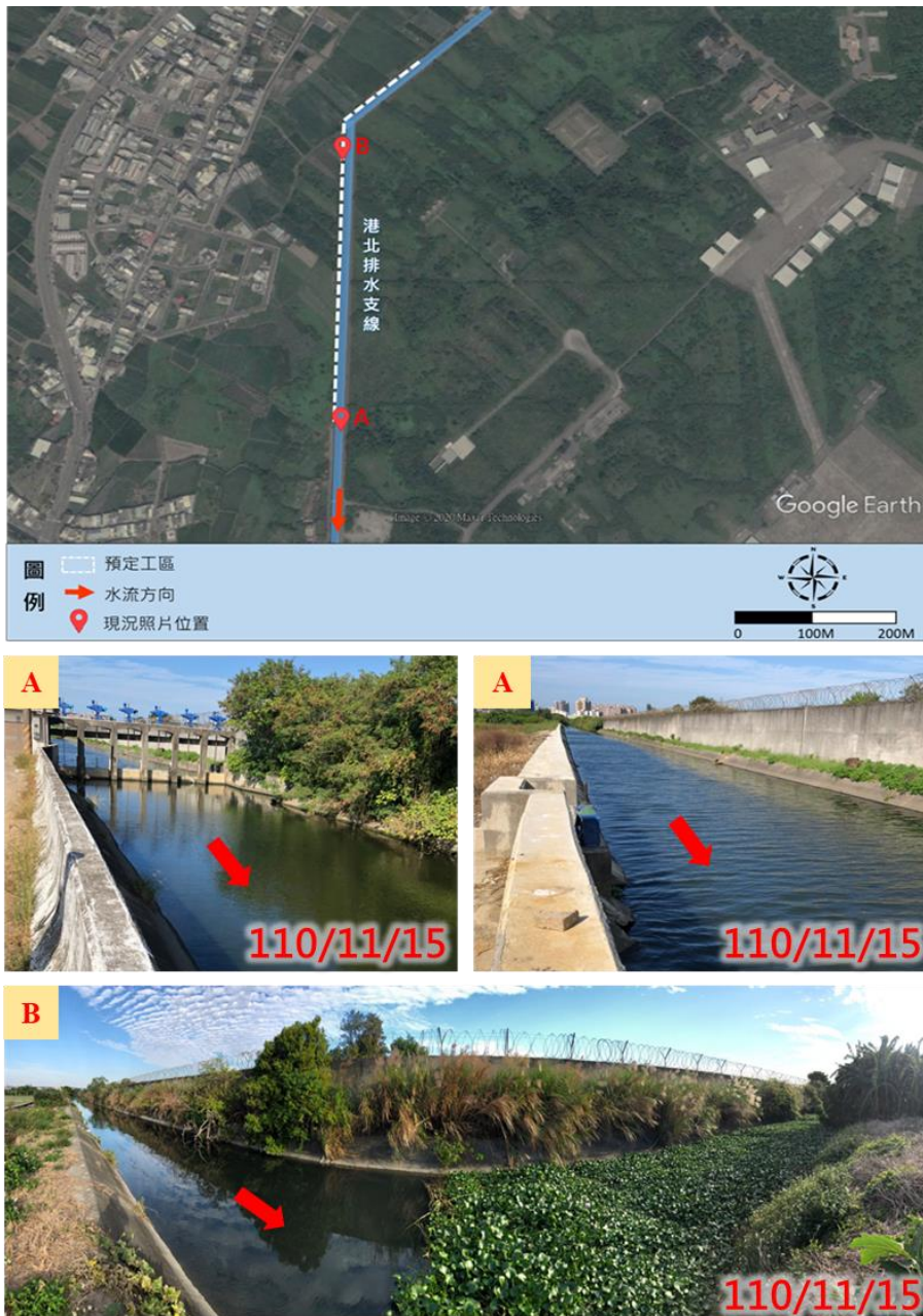
圖 2-37 港北排水支線(3K+091~3K+791)右岸護岸加高應急工程之環境現況照
