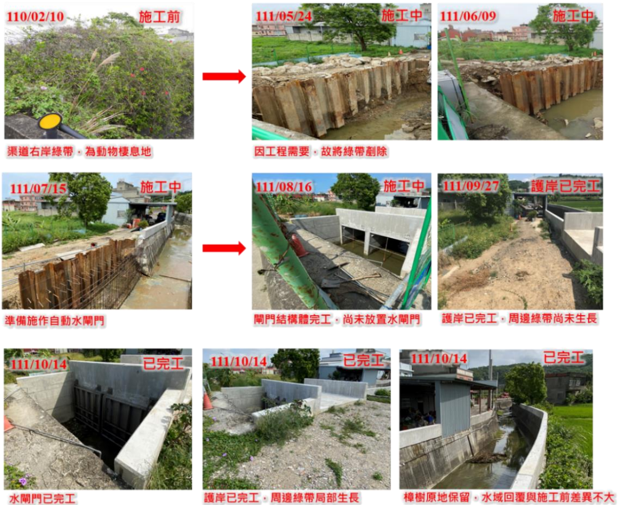
圖 2-28 頂寮溪排水改善工程施工階段生態監測
