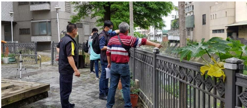
圖 18 東大排水(河心累距 1K+789~2K+004)護岸改善應急工程施工前教育訓練
