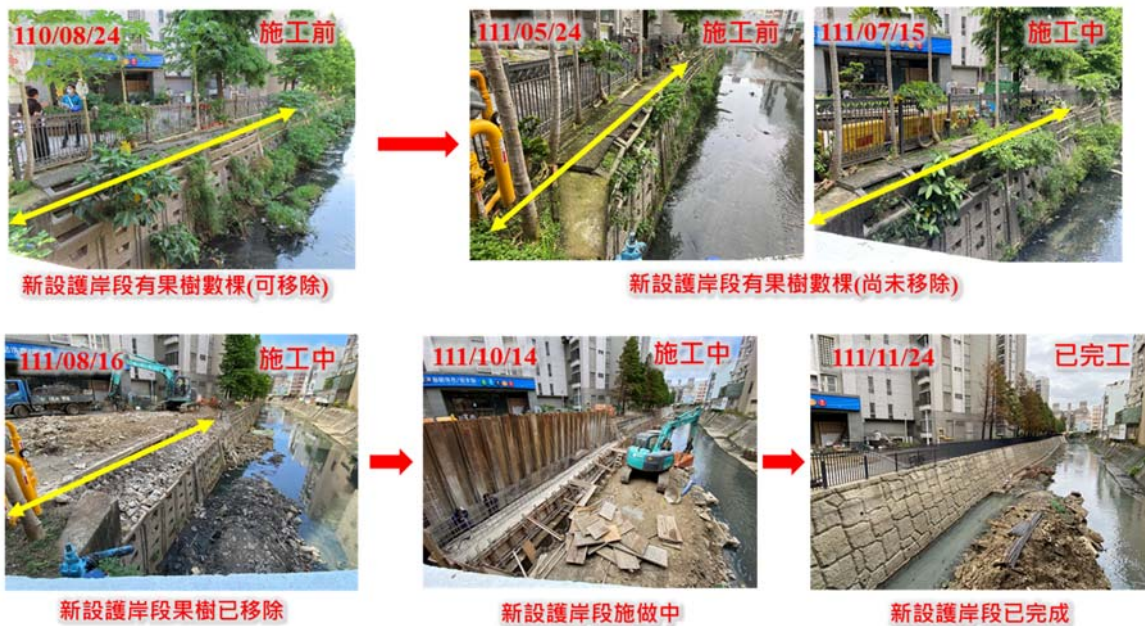
(a) 施工前、中、後新設護岸段之喬木移除與工程施做情況
