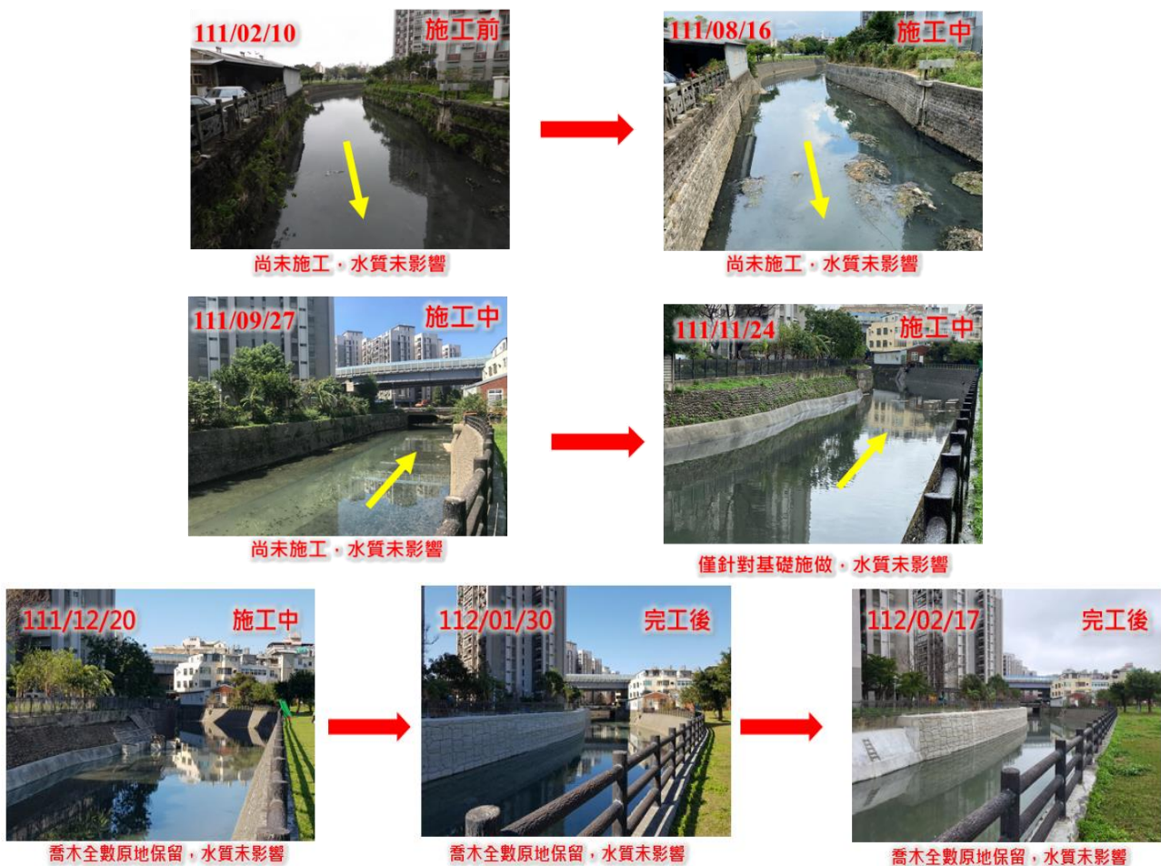
圖 2-19 東大排水(河心累距 2K+044~2K+229)護岸改善應急工程生態監測
