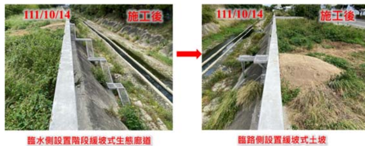
施工後之生態廊道照片
