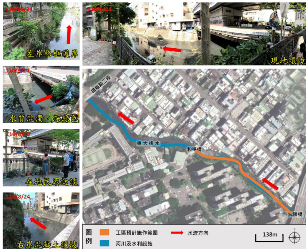
圖 2-8 東大排水(河心累距 1K+789~2K+004)護岸改善應急工程環境現況圖
