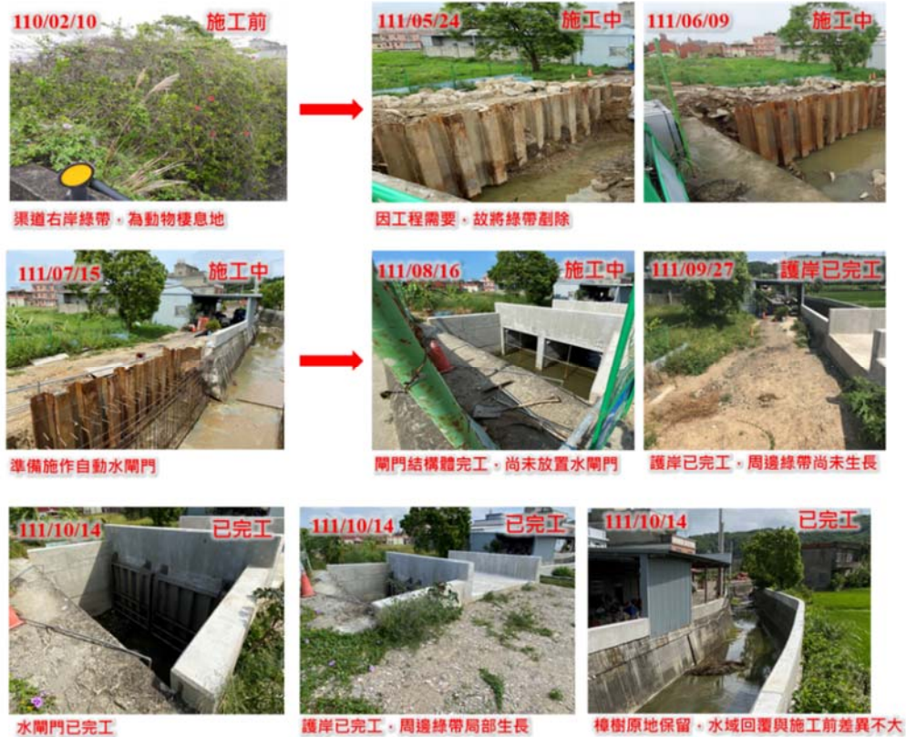
圖 35 頂寮溪排水改善工程施工階段生態監測
