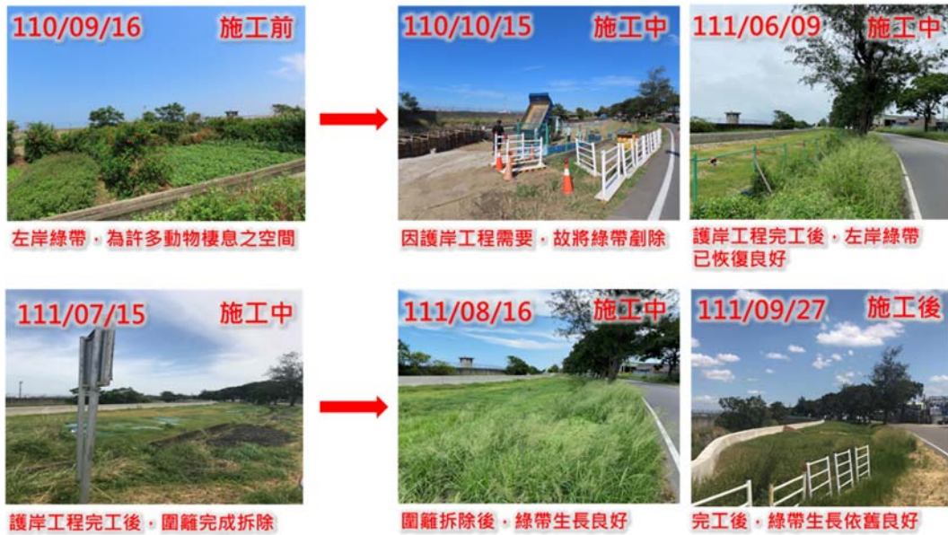
施工前、中、後之工區植被情況
