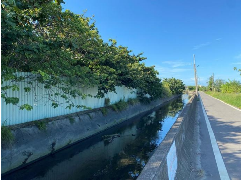
圖 2、港北溝施工後狀況與施工前變化不大
