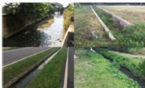
圖 2.2-2 工區範圍內垂直型護岸溝渠
