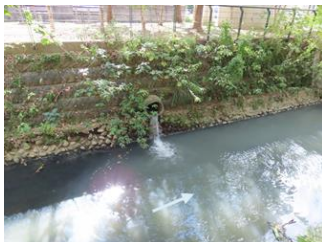
建功國小附近加勁工法
