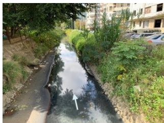
赤土崎公園附近右岸僅有低水護岸，其上為部分土坡
