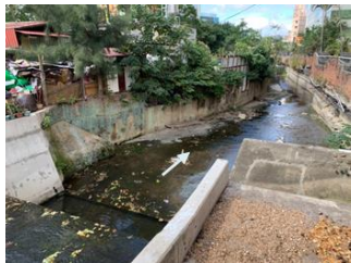
東園國小附近RC護岸區域
