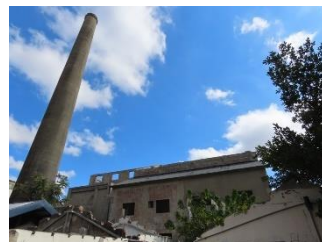
六燃場煙囪與周邊民宅屋頂裂隙為霜毛蟻生殖族群利用之棲地
