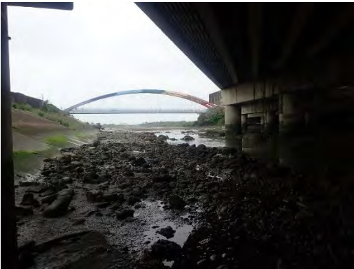
出海口泥沙淤積嚴重，水色混濁
