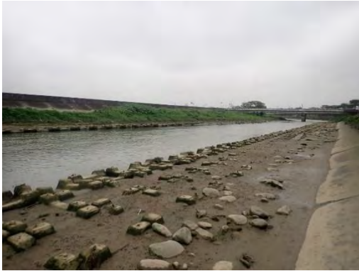
兩側皆為混凝土岸，左岸大面積消波塊
