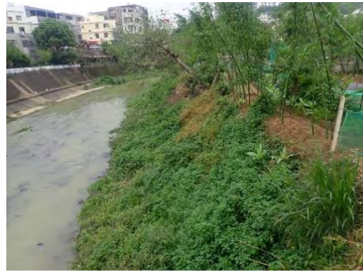
左岸為混擬土岸，右岸為自然土堤
