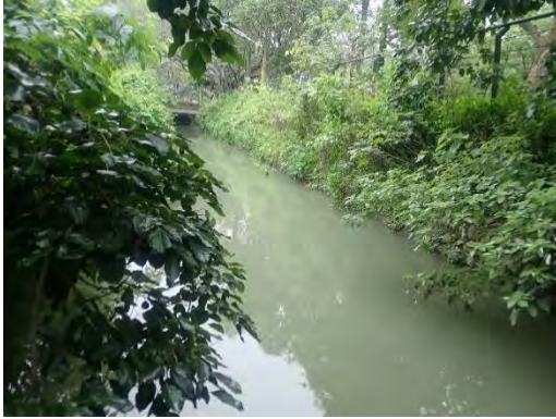
兩側為網籠護岸及自然土堤
